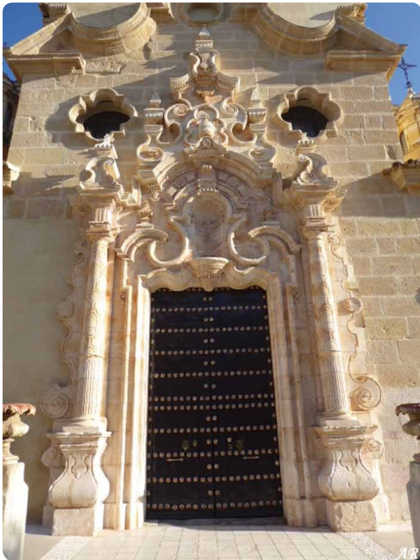
Fachada principal de la Parroquia Santa María del Reposo de Campillos, del arquitecto D. Antonio Matías de Figueroa, realizada en 1773, restaurada en su ornato original. Así como la imagen de la Virgen que se encuentra en la parte central, magníficamente decorada y coronada. Año 2018
