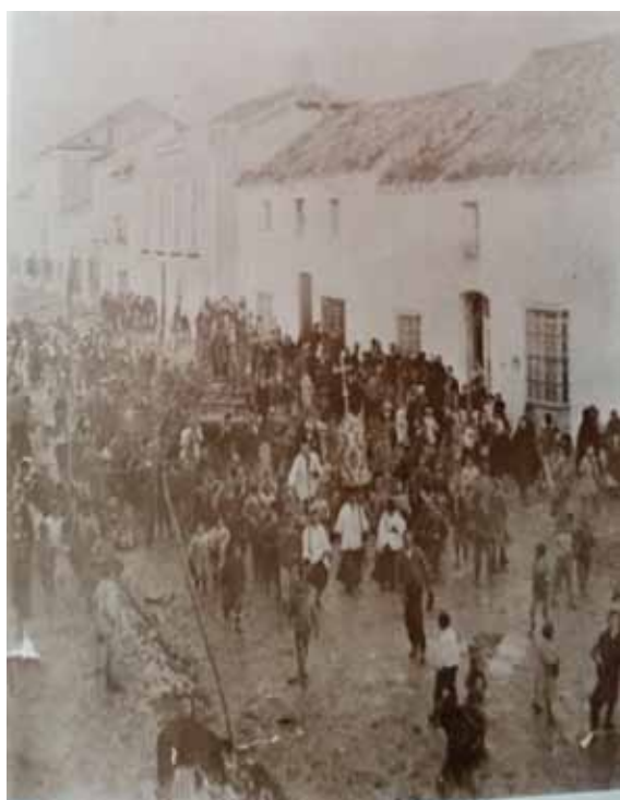
Traslado a la iglesia a su paso por c/ Real
